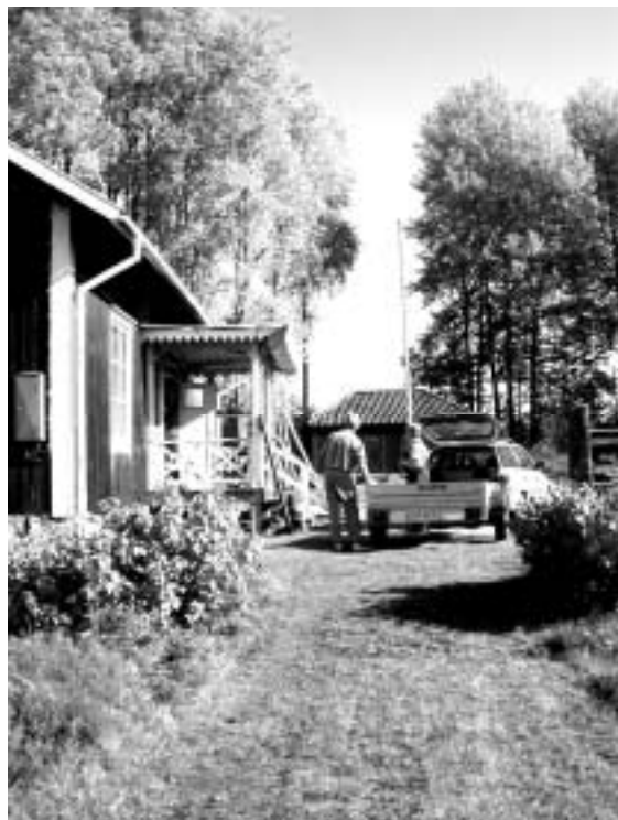
Renoveringen av Bjørsbo fortgår
